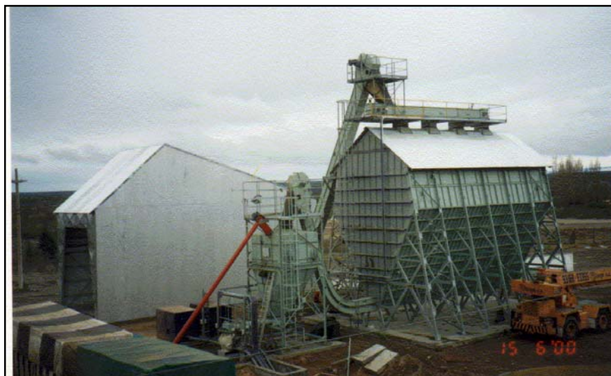
Instalaciones de almacenamiento y dosificación
