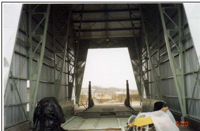
Vista interior de la plataforma de descarga
